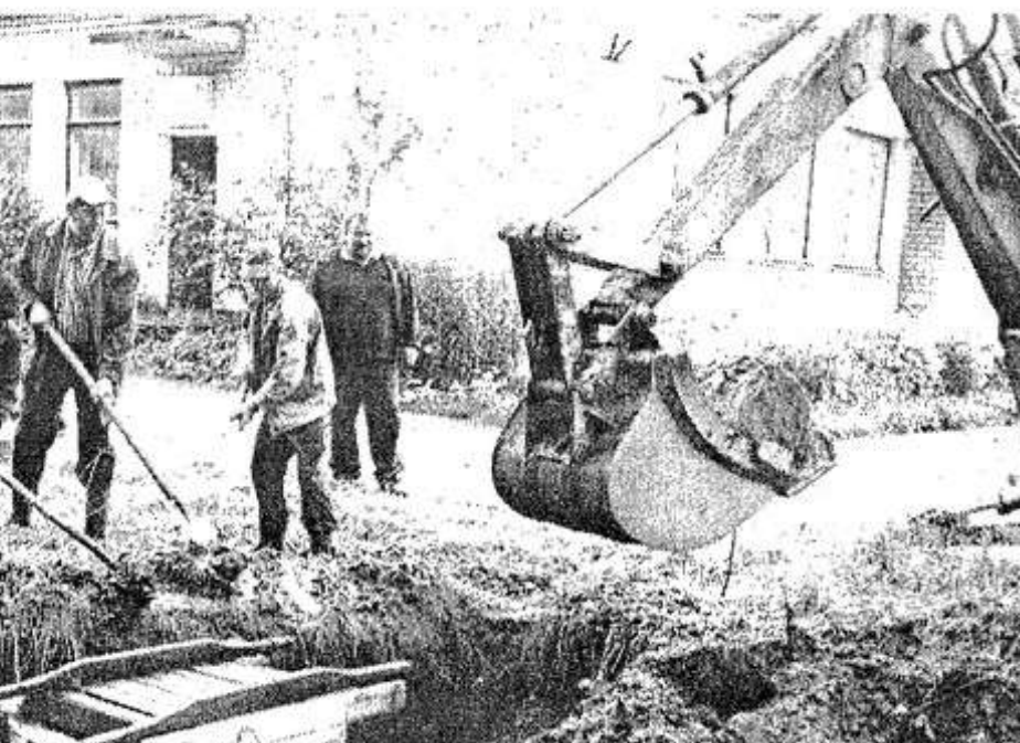
Глава волости В.Федин и работники «Коммунсервиса» на строительстве колодца.
