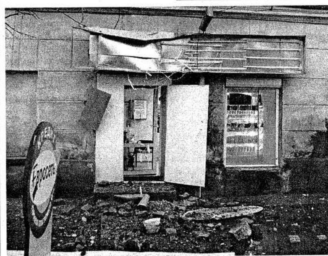
того, что кирпичи от ветхого карниза будут отставать и дальше. Еще одна версия: причина обрушения кирпичной кладки может скрываться в укоренившихся на крыше здания деревьях. По крайней мере, если внимательно присмотреться к карнизу в месте его разрушения, то нельзя не заметить свисающих на стену длинных, узловатых корней неизвестного дерева.
