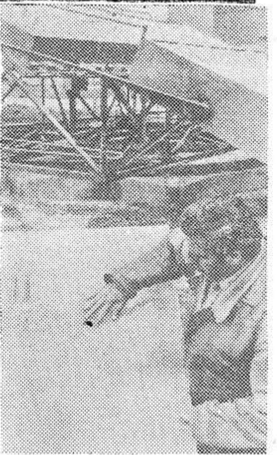
НА СНИМКЕ: укладка полиуретановой сетки. Фото ЧТК — ТАСС.
