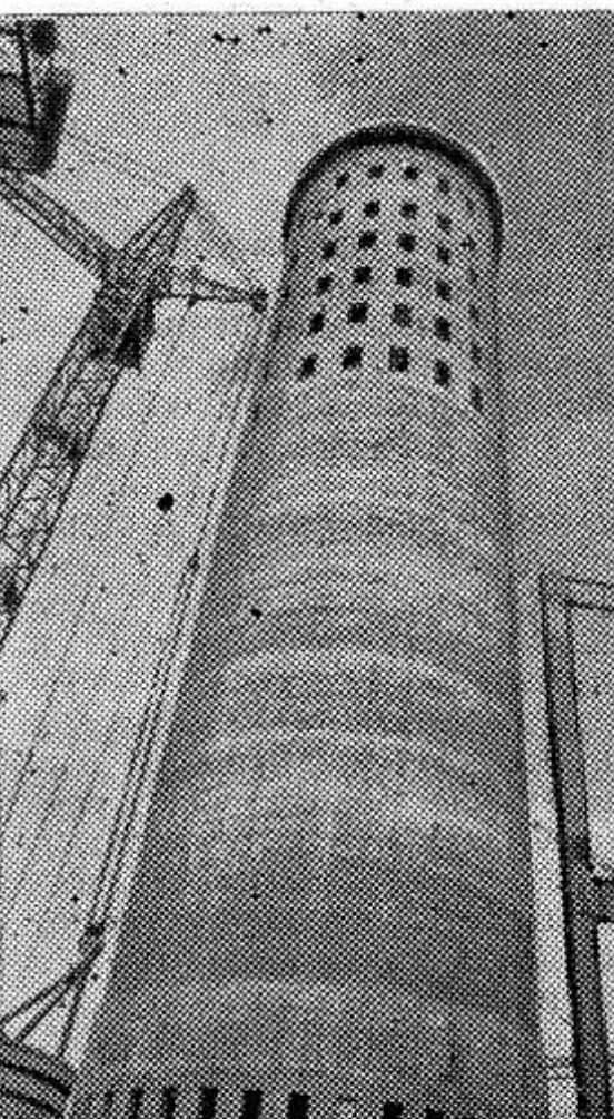
В Новгородском производственном объединении «Азот» закончено сооружение башни грануляции. Ее высота — 117 метров, диаметр составляет 28 метров. Башня возводилась методом скользящей опалубки.
