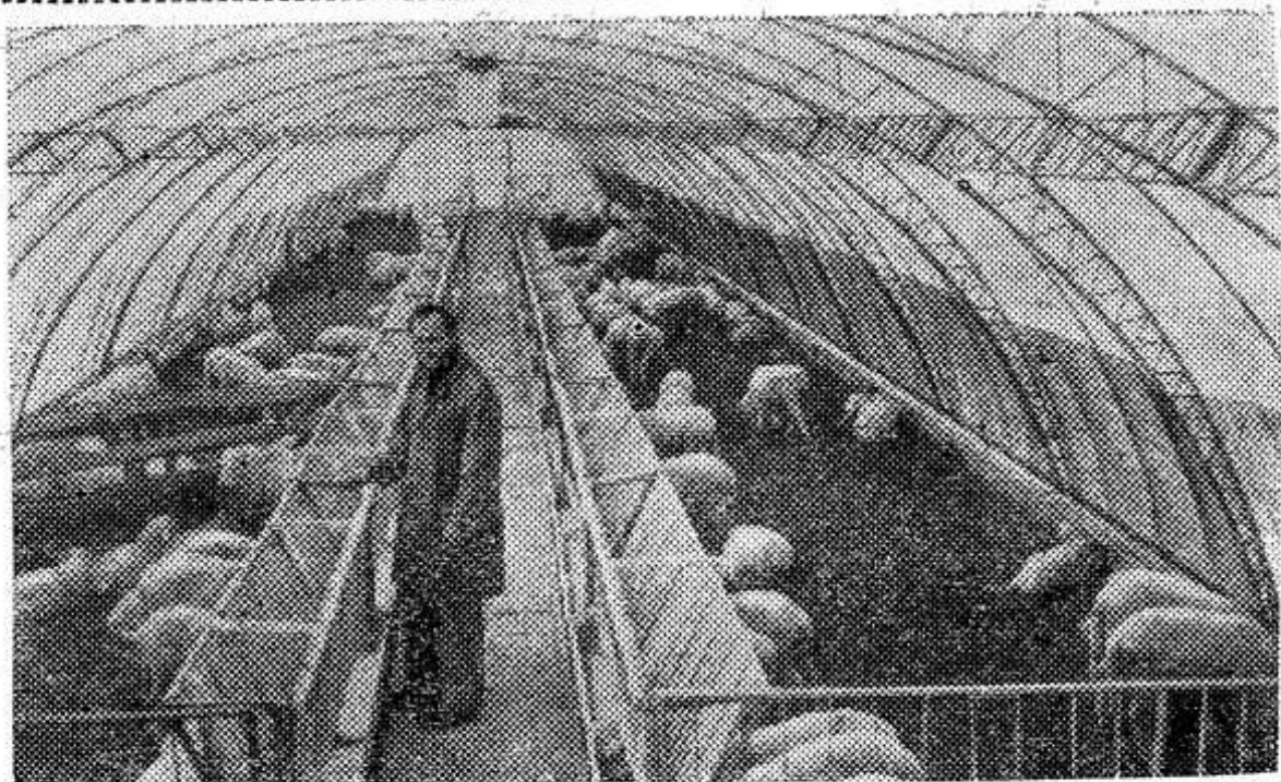
БОЛГАРИЯ. В аграрно-промышленном комплексе имени Васила Коларова, близ города Первомай, для откорма овец построено оригинальное, похожее на теплицу, помещение. Его металлический каркас обтянут полиэтиленовой пленкой, армированной плотном. Фото БТА — ТАСС.
