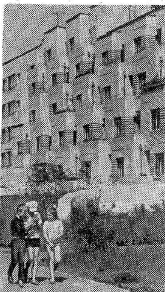
ЛЕНИНГРАДСКАЯ ОБЛАСТЬ. В благоустроенный поселок превращается центральная усадьба совхоза «Агротехника» сельскохозяйственного производственного объединения «Тосненское». Здесь поднялись современные
