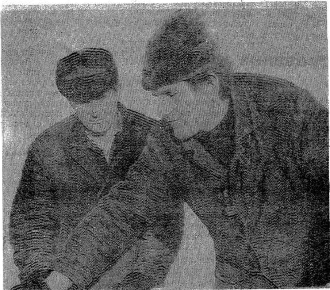
Полным ходом идет строительство нового хлебокомбината. На объекте хорошо трудится бригада бетонщиков ПМК-538, которую возглавляет В. Г. Васильев. Несмотря на суровые зимние условия, она выполняет свои за-
