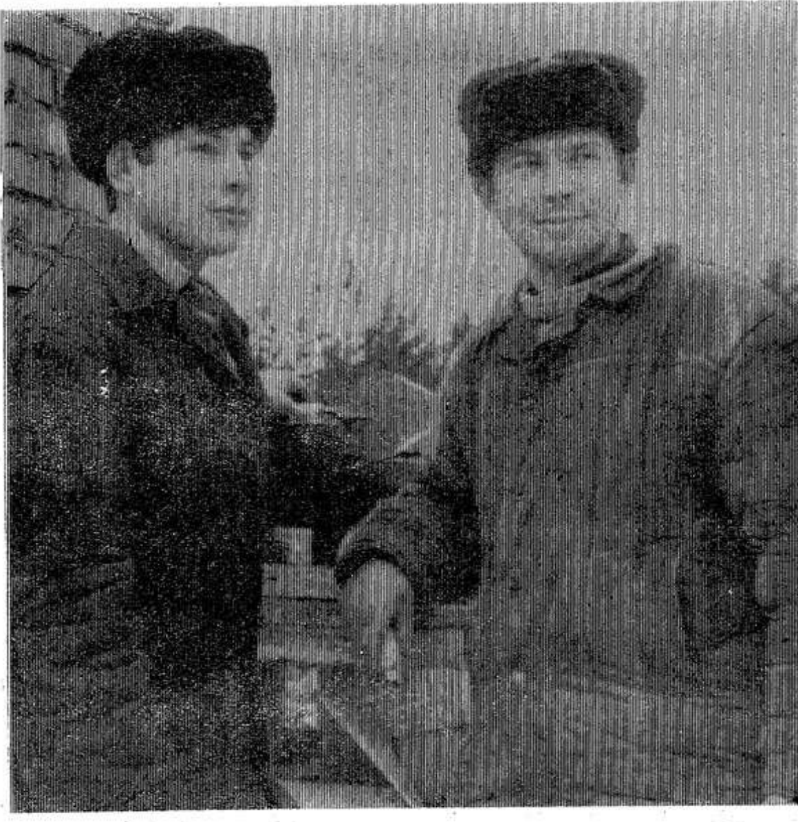
Растет поселок Приозерный. Уже изданы видны строящийся корпуса производственных и бытовых зданий. Возводят их строители будущего торфобрикетного завода.
