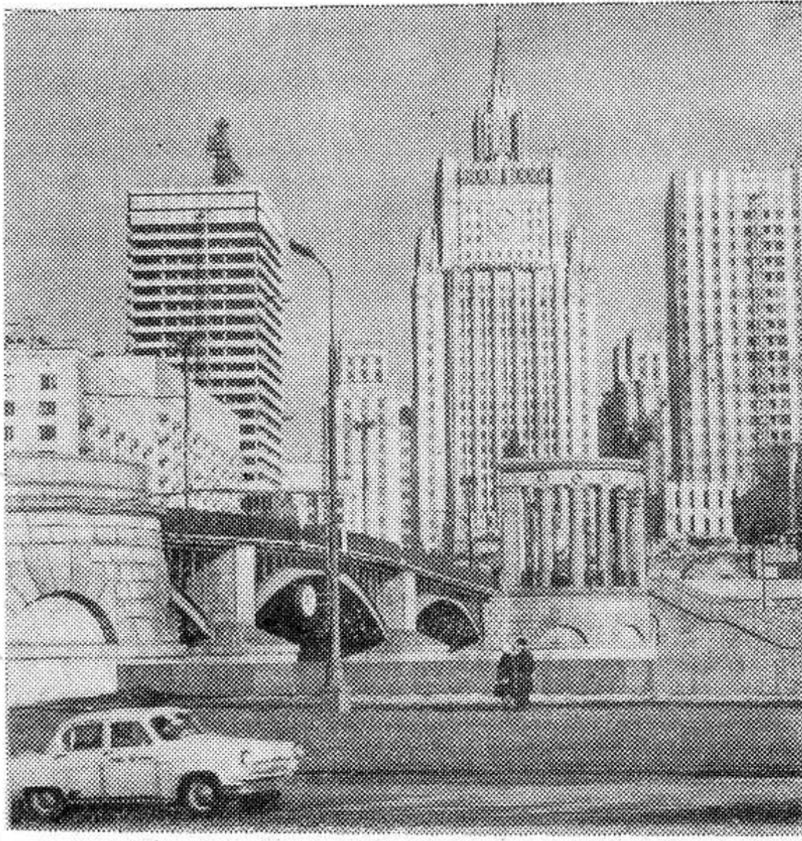
МОСКВА. В столице ведется большое строительство. НА СНИМКЕ: вид со стороны Бережковской набережной на строящийся корпус гостиницы «Интурист» (слева) на Смоленской площади.
