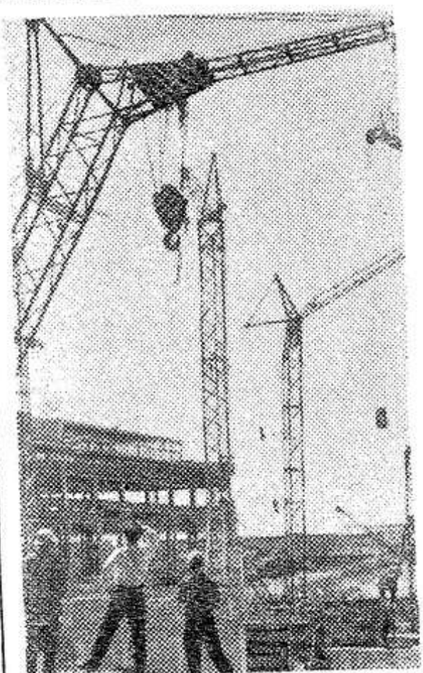
На Челябинском тракторном заводе идет реконструкция, связанная с подготовкой к производству тракторов «Т-130». Сооружается несколько новых цехов. Один из них — прессово-сварочный будет иметь площадь 88 тысяч квадратных метров. Строители решили полностью сдать здание под монтаж оборудования к 25 декабря текущего года. НА СНИМКЕ: на строительстве прессово-сварочного корпуса. Фото Б. Клипинцера. Фотохроника ТАСС
