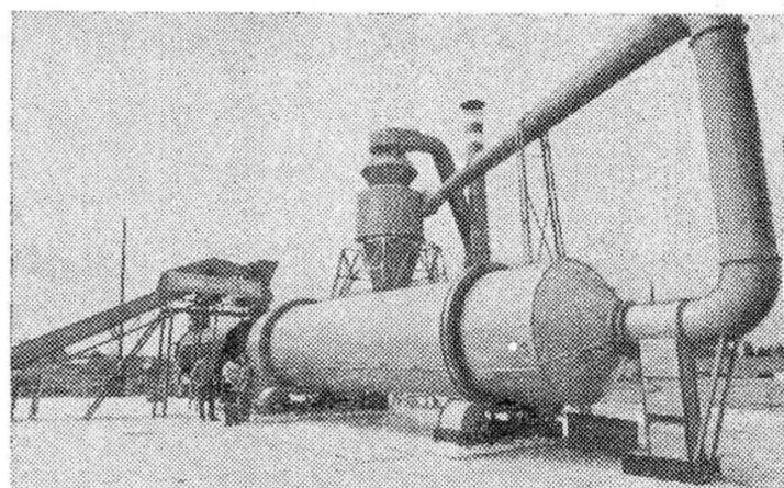
«АСТРА» — так называется созданный на Экспериментальном заводе древесно-стружечных плит и деталей Министерства лесной и деревообрабатывающей промышленности СССР агрегат для сушки кормов — травяной резки, фуражного зерна и предварительно измельченных корнеплодов. Обслуживают агрегат три человека. Его производительность — 2-3 тонны сухого продукта в час. Управление и контроль за работой агрегата автоматизированы и
