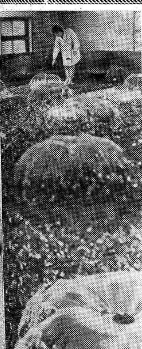
Снимок сделан на станции биологической очистки сточных вод свинооткормочного комбината «Новый свет», что под Ленинградом. Загрязненная промышленная вода, используемая в технологическом цикле, не сбрасывается в природные водоемы, а после тщательной очистки вновь поступает в производство. Получается замкнутый водяной контур, что позволяет сохранить окружающую комбинат природу. Новая станция может обрабатывать выше 700 кубометров в сутки.
