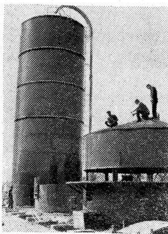
На Киргизской Государственной зональной машино-испытательной станции сооружаются четыре сенажных башни. В каждую из них в этом году будет заложено по сто двадцать тонн зеленой массы. Оборудование для башни изготовлено в братской Чехословакии фирмой «Витковице». Башни высотой 16 и диаметром 6 метров монтируются под руководством чехословацкого инженера Йозефа Одрибника.
