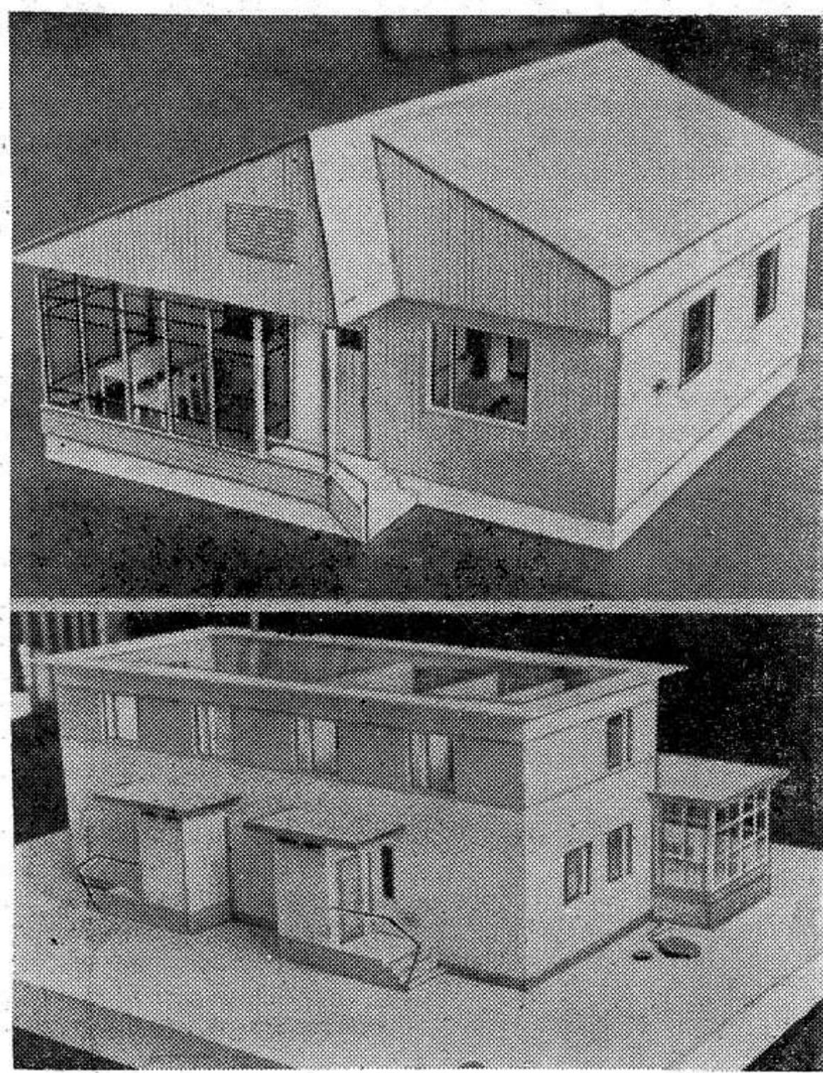
Экспериментальный проект жилого дома с 4-комнатными квартирами в двух уровнях со стенами из ячеистобетонных блоков.
