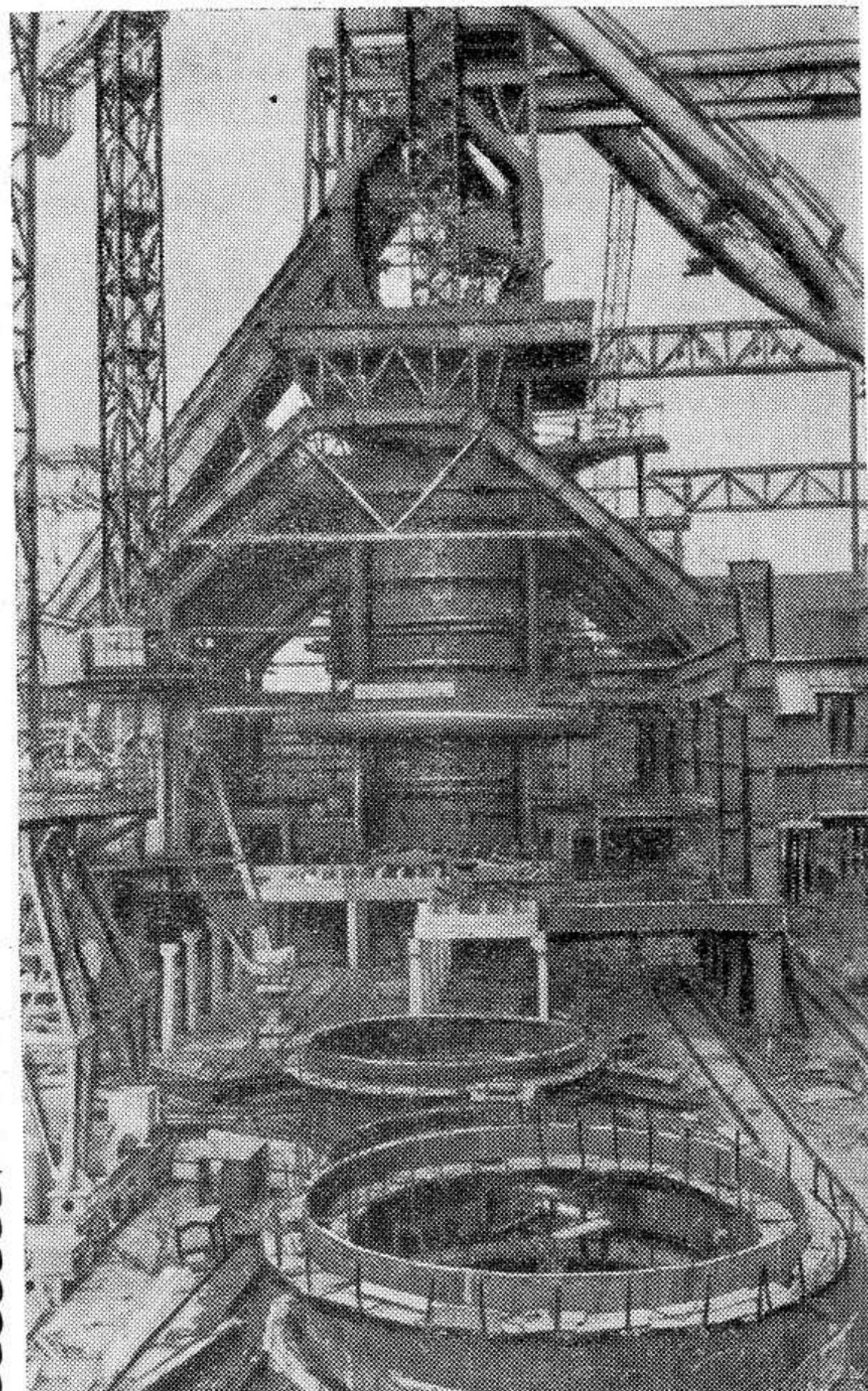
Вологодская область. В текущем году должна будет дать первый чугун мощная доменная печь объемом 2700 кубических метров, строящаяся на Череповецком металлургическом заводе. Более ста предприятий страны участвуют в сооружении домны-гиганта. На строительной площадке встают величественные конструкции. О размерах работ говорят такие цифры: предстоит уложить около 140 тысяч тонн бетона, смонтировать
