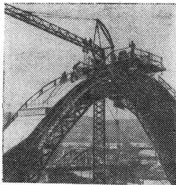
На снимке: строительство электростанции Жидоштица в районе Железных ворот.
