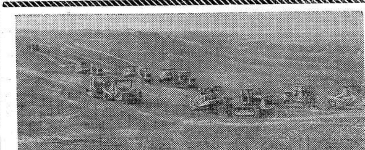
УЗБЕКСКАЯ ССР. В Голодной степи создается искусственное море. Воды Джизакского водохранилища напоят влагой тысячи гектаров целинных земель. А сейчас здесь трудятся строители. Началась отсыпка дамбы, бетонирование откосов. НА СНИМКЕ: на строитель-
