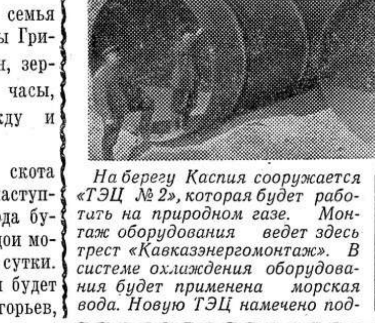
На берегу Каспия сооружается ТЭЦ № 2, которая будет работать на природном газе. Монтаж оборудования ведет здесь трест «Кавказэнергоаппарат». В системе охлаждения оборудования будет применена морская вода. Новую ТЭЦ намечено под-
