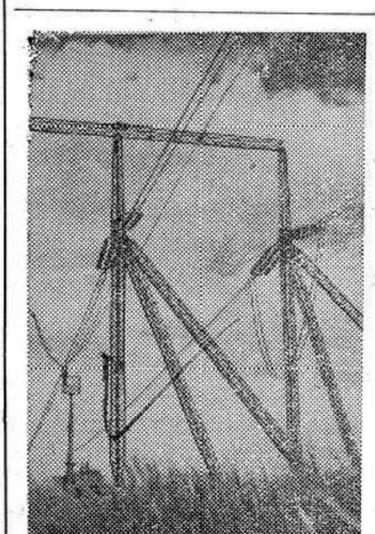
ВОЛГОГРАДСКАЯ ОБЛАСТЬ. Коллектив строителей и монтажников Волгоградэлектростроя соорудил уникальную линию электропередачи напряжением 800 киловольт Волгоград — Донбасс. В третьем квартале по этому проводу пойдет ток Волжской ГЭС имени XXII съезда КПСС. НА СНИМКЕ: участок строительства линии электропередачи между Волгой и Доном.
